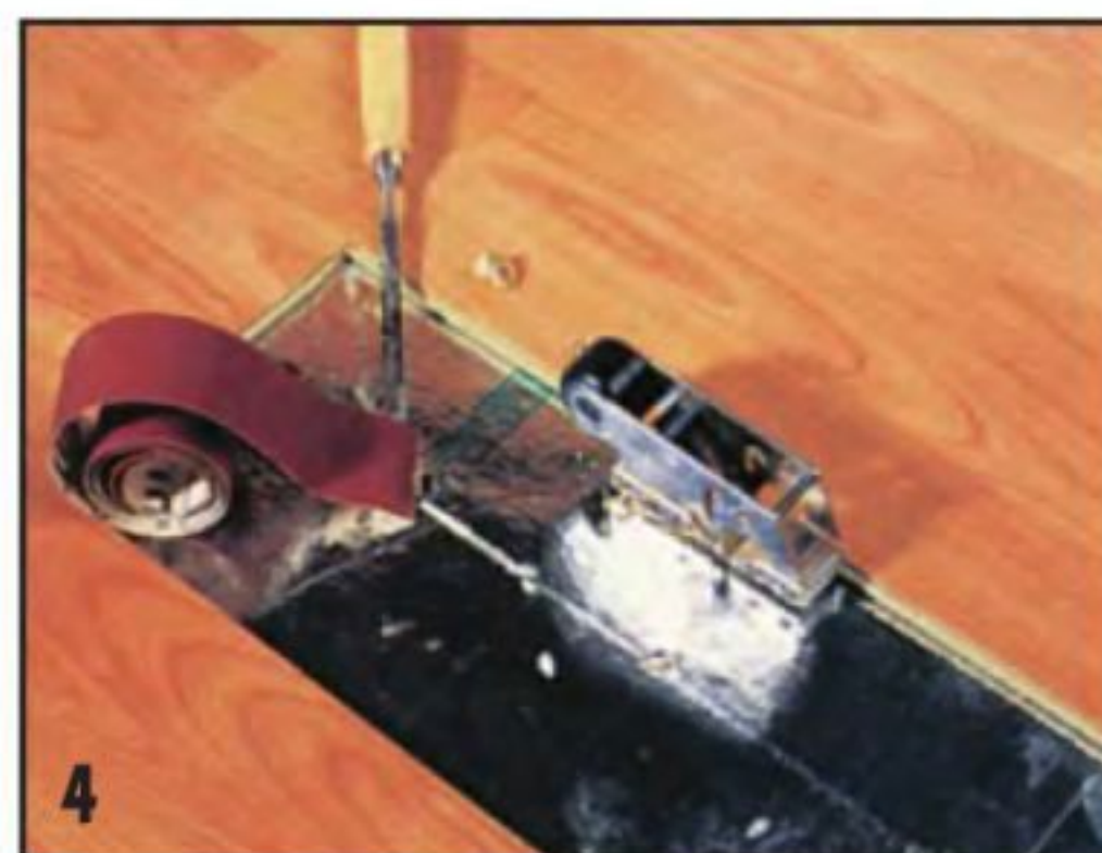
4 Пазы и гребни неповрежденных досок покрытия тщательно зачищают. Наряду со шкуркой и стамеской полезен здесь будет и рубанок.
