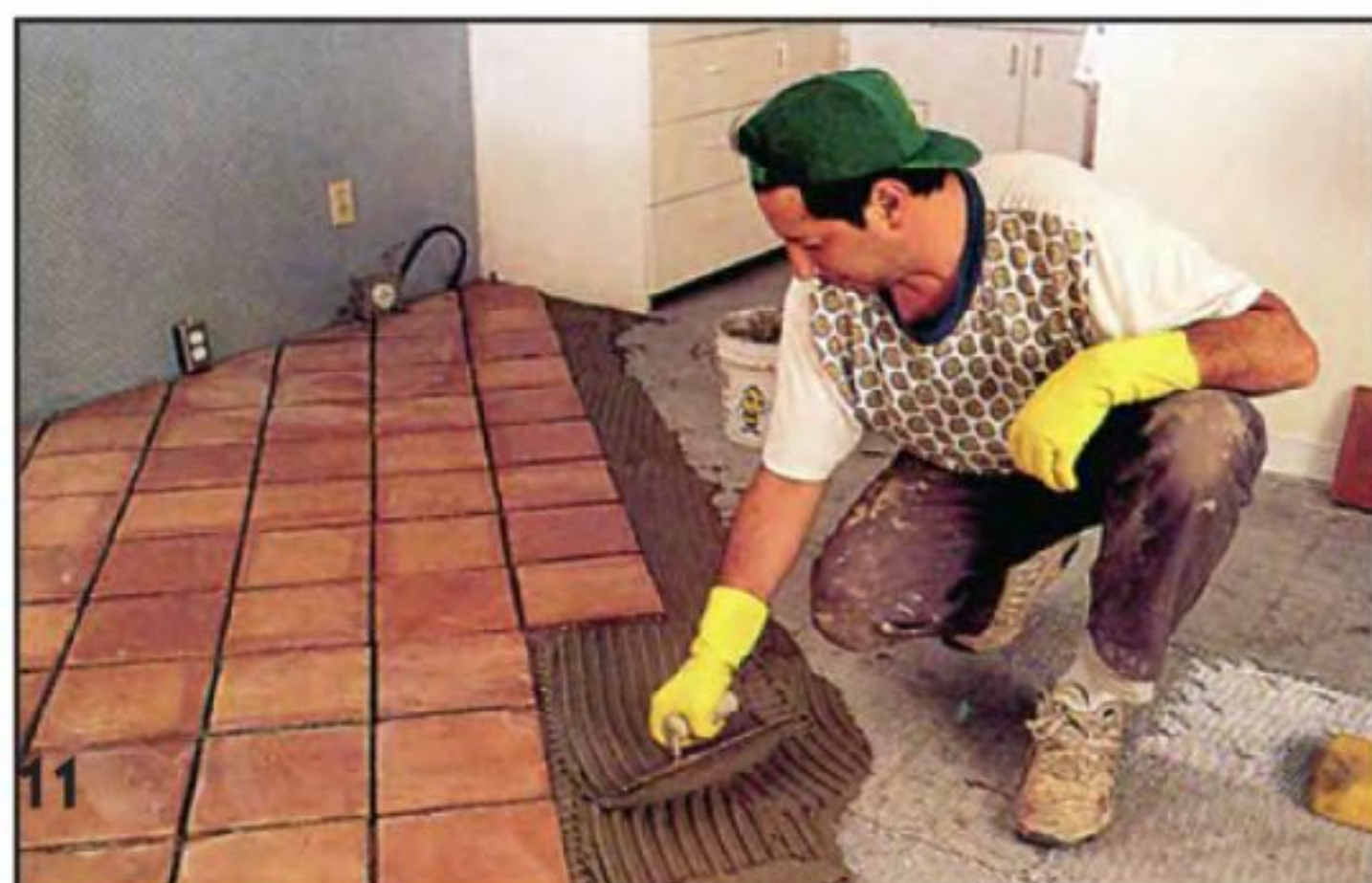
11 Если не причёсывать клей зубчатым шпателем, его излишки будут выступать в швы между плитками. Чтобы уложить плитки по прямой и с одинаковым шагом, лучше укладывать их последовательно по одному ряду.
