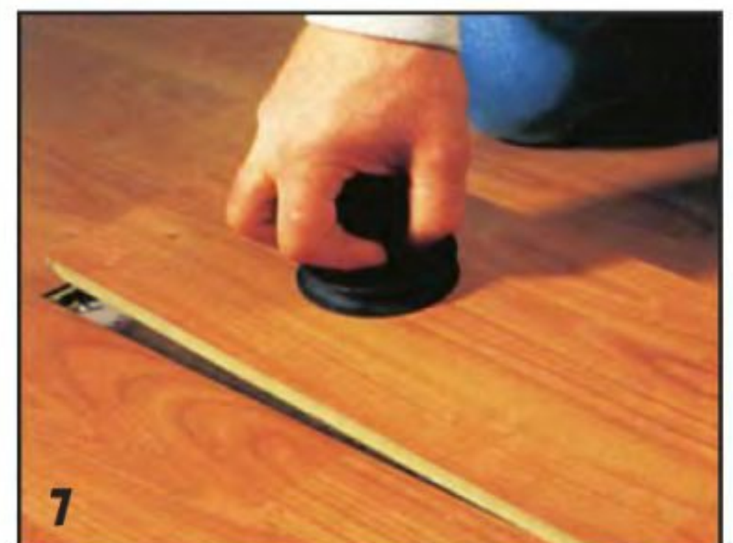
7 Подготовленную новую доску примеривают к проему. Наносят клей в пазы и на гребни склеиваемых досок ремонтируемого участка и вставляют новую доску на место.
