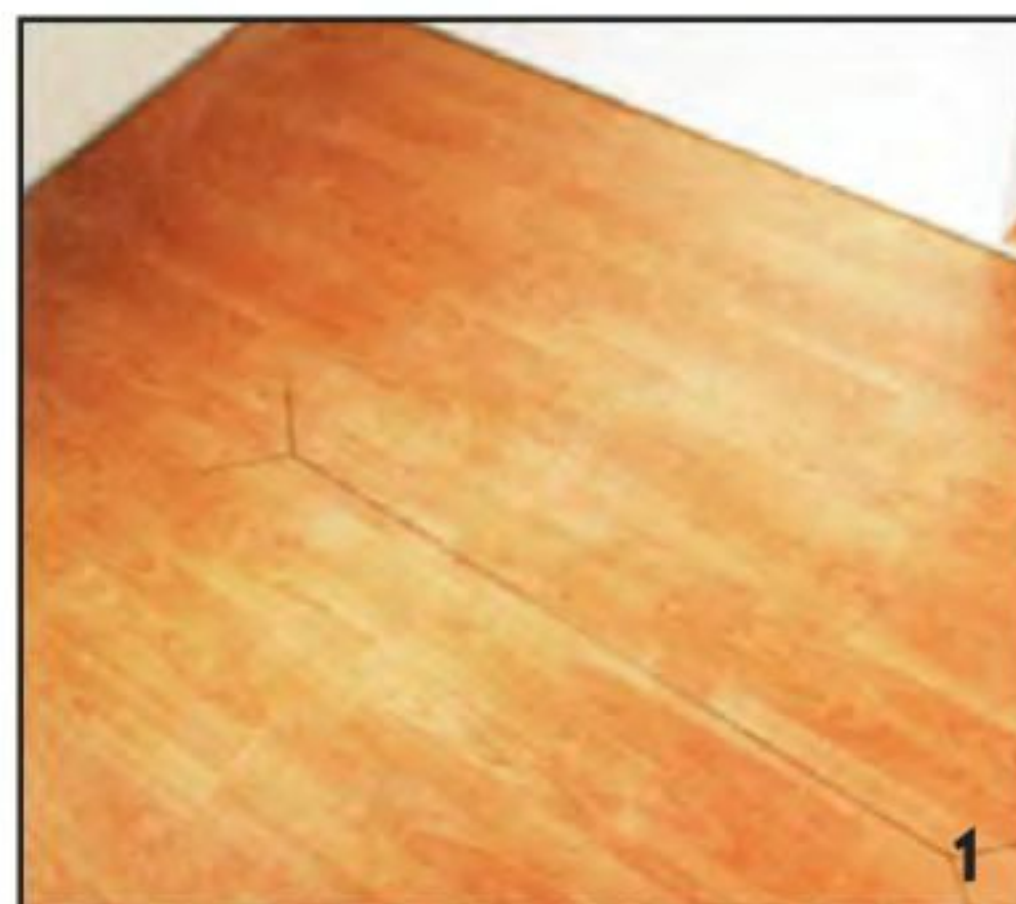
Размечают пропилы на повреждённой половице.
