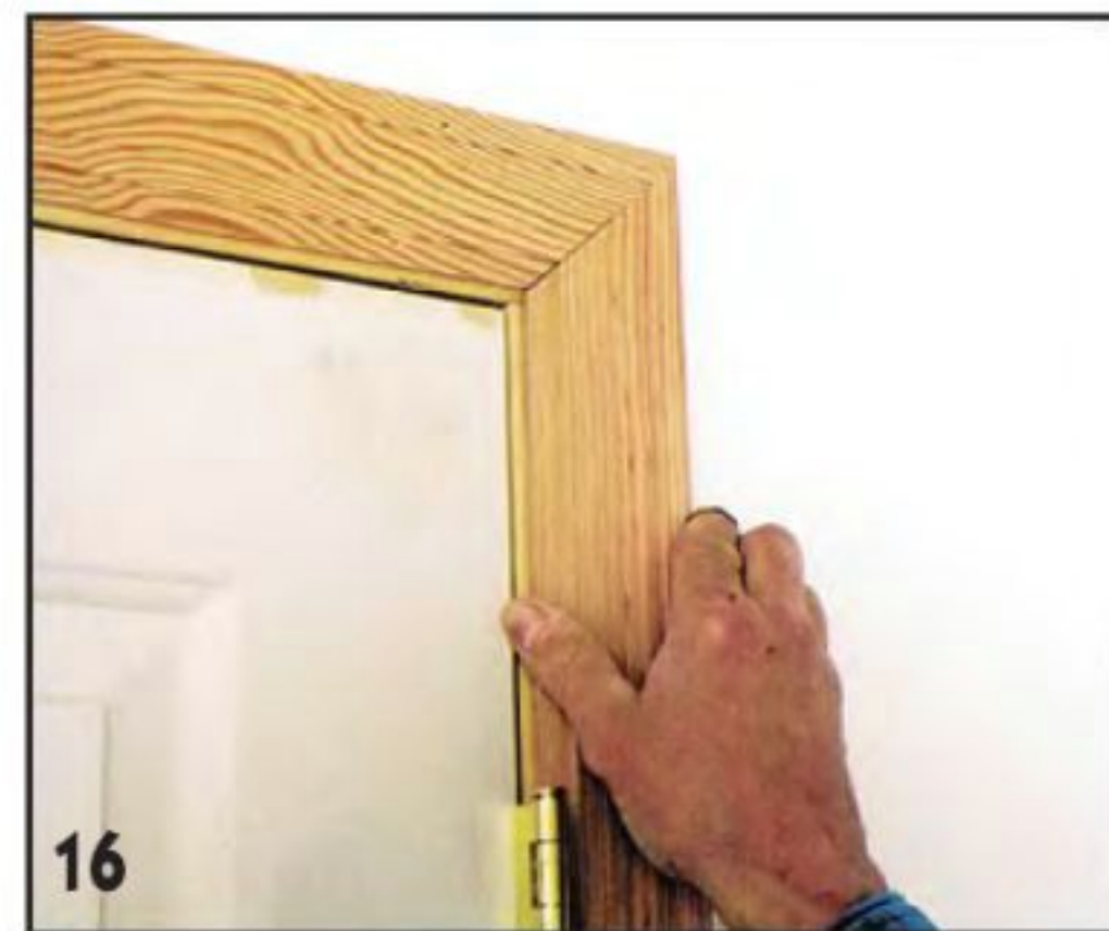
16 Подшлифовывая наличник, добиваются приемлемого соединения «на ус». Щель заделывают шпатлевкой.
