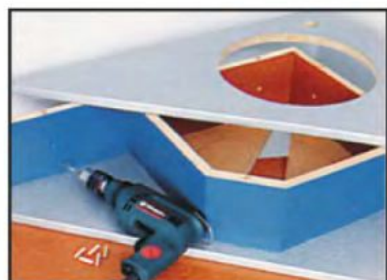
Полка для встроенного умывальника подготовлена к установке на место. Верхняя крышка не закреплена.
