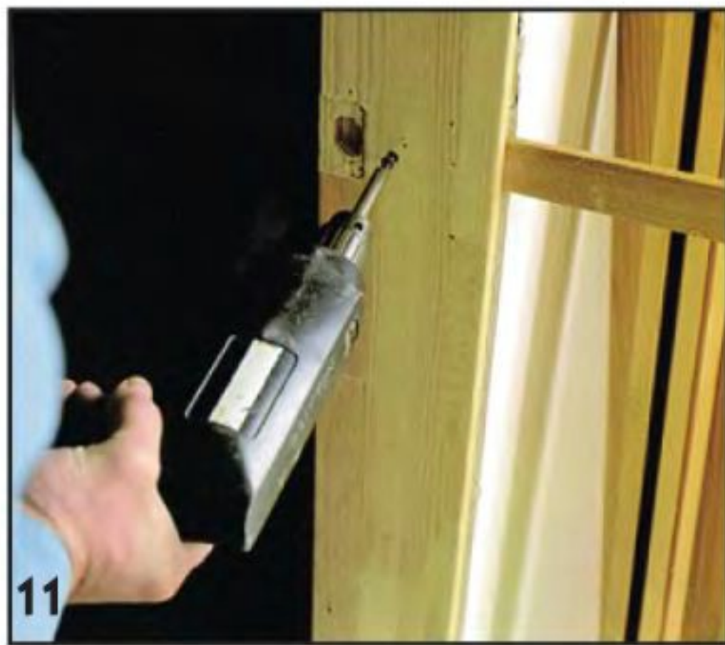
11 Ставят запорную планку. Сняв ограничитель хода, вворачивают в замочную обвязку рядом с замком шуруп.
