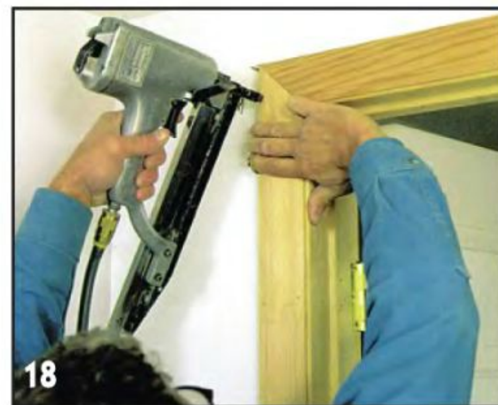
18 Обрезав клин, прибивают углы наличников гвоздями к горизонтальной и вертикальной обвязкам коробки и к стене. Все зазоры между стеной и наличниками шпатлюют.
