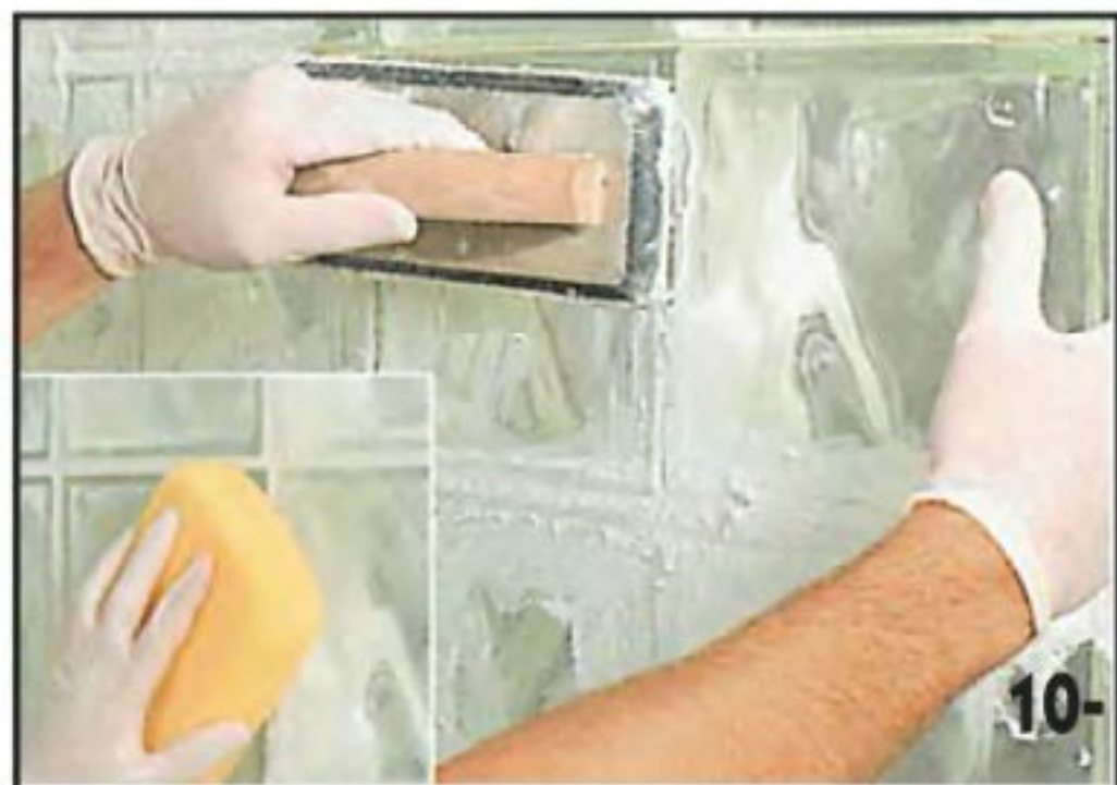
10- Примерно через сутки после завершения кладки межблочные швы заполняют водостойким затирочным раствором.
