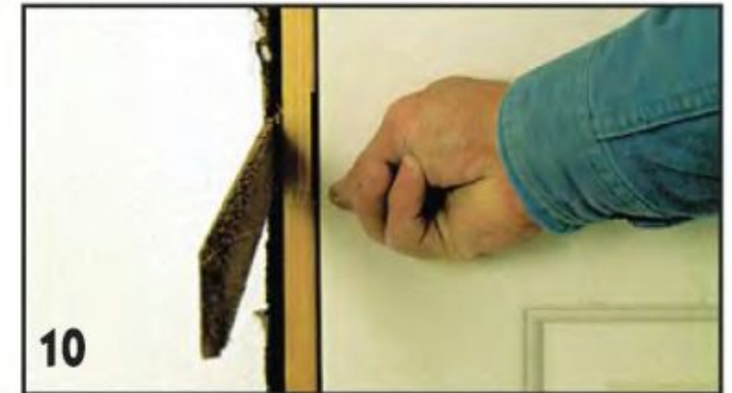
10 Крепят обвязки. Выравнивают зазор у замочной обвязки. С помощью клиньев, установленных в зоне замка, регулируют положение замочной обвязки до получения равномерного зазора сверху донизу.
