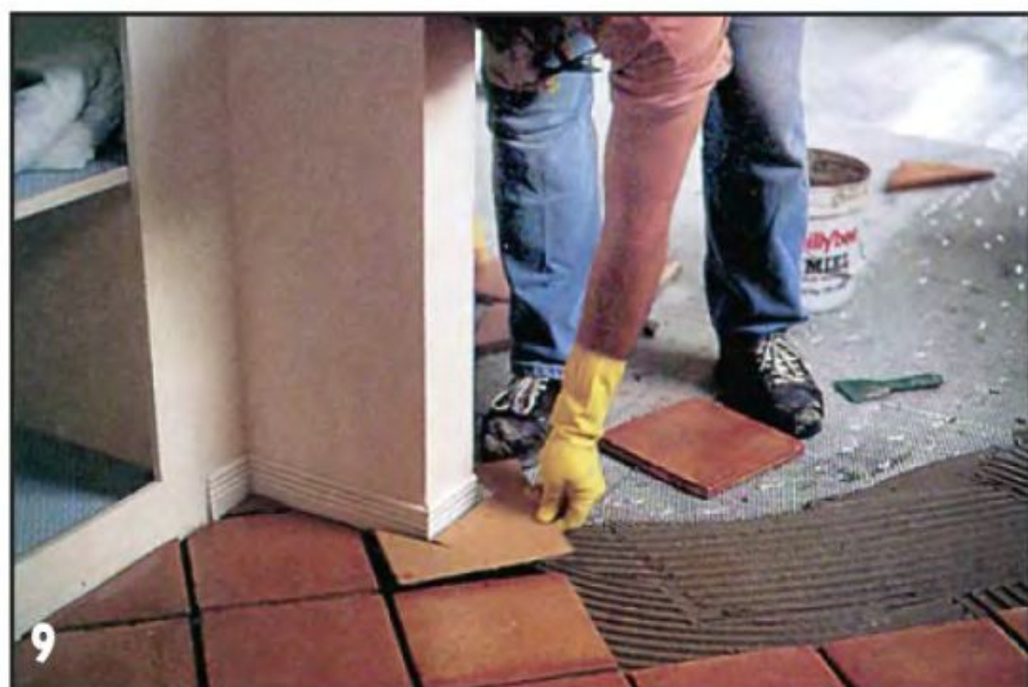
9 При диагональной укладке в плитках наверняка придётся делать вырезы сложной формы. Картонные шаблоны для них делают только после укладки на место окружающих плиток.
