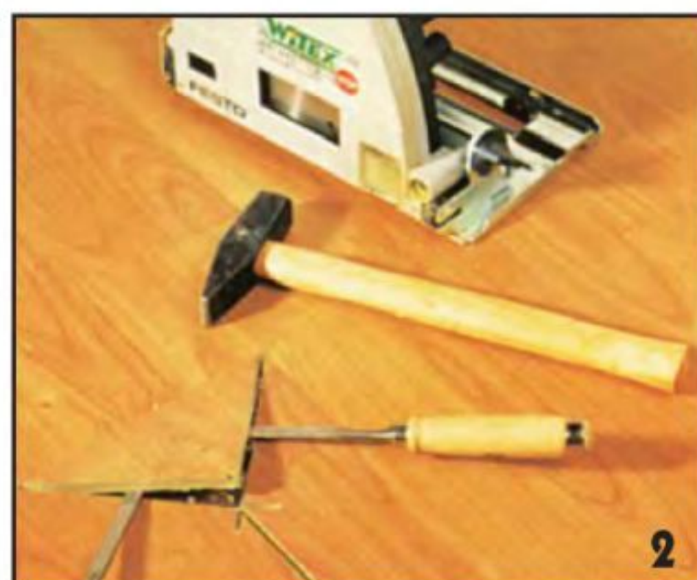
Электропилой по размеченным линиям делаютрезы и удаляют оба треугольных сегмента, сорвав их с клея.
