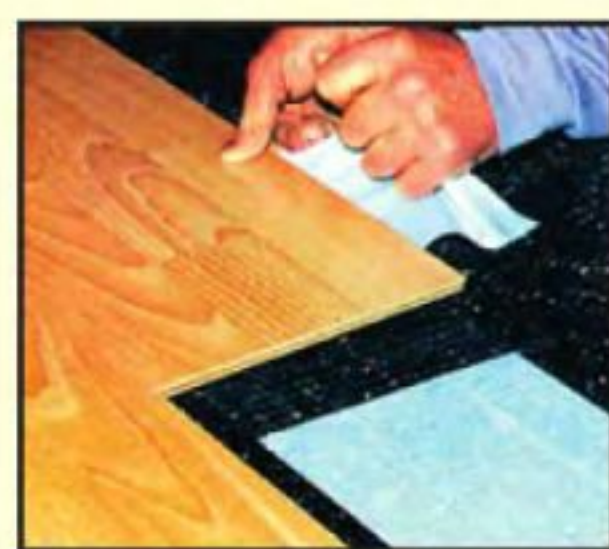
Аккуратно стянув защитную плёнку, элемент прижимают к клейкой поверхности.
