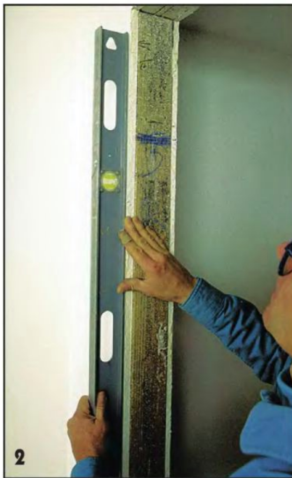
2 Если для обеспечения вертикальности двери обвязка коробки будет выдаваться за поверхность стены, направление сдвига отмечают на стойке (или торце стены). Во избежание ошибок на полу отмечают направление открывания двери.
