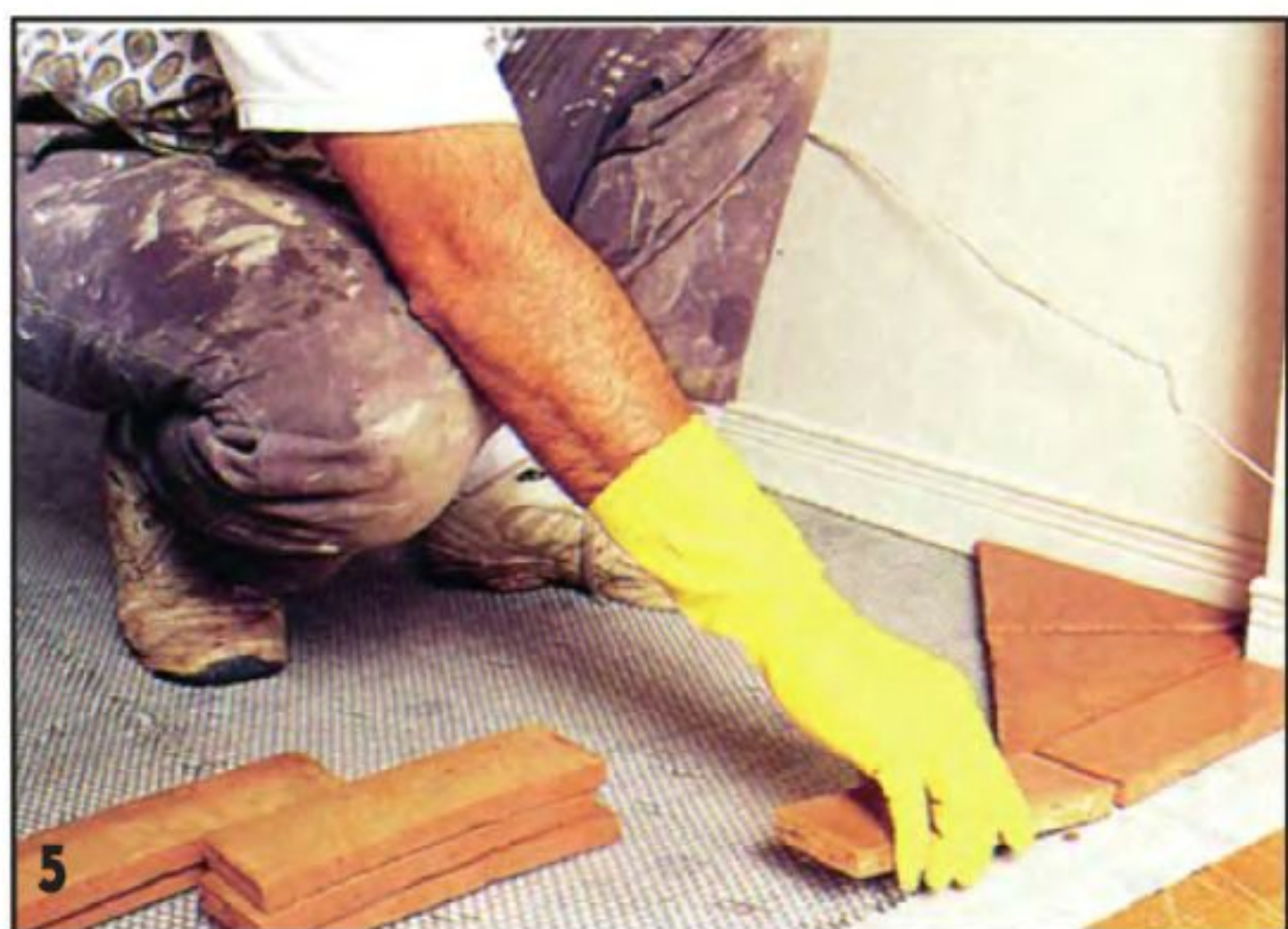
В ответственных местах до нанесения клея желательно уложить плитку насухо и проверить правильность подгонки. Резиновые перчатки не дадут плитке выскользнуть из рук.
