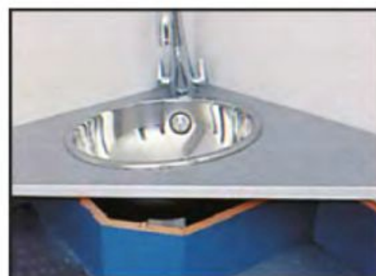
Монтируют на верхней крышке раковину и смеситель, устанавливают крышку на полку и подключают сантехнику.
