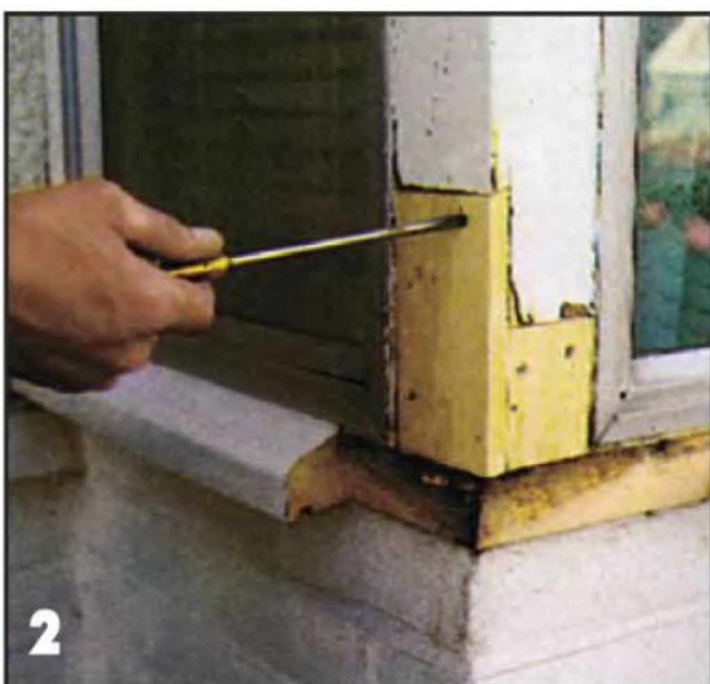
2 Вырезанные прямоугольные фрагменты оконной коробки заменяют вставками соответствующей формы, прикрепляемыми на водостойком клее и нержавеющей шурупах.
