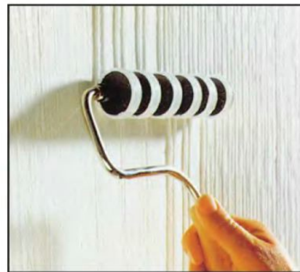
Рисунок и равномерную и неравномерную «полоску» можно сделать с помощью резинового рельефного валика.
