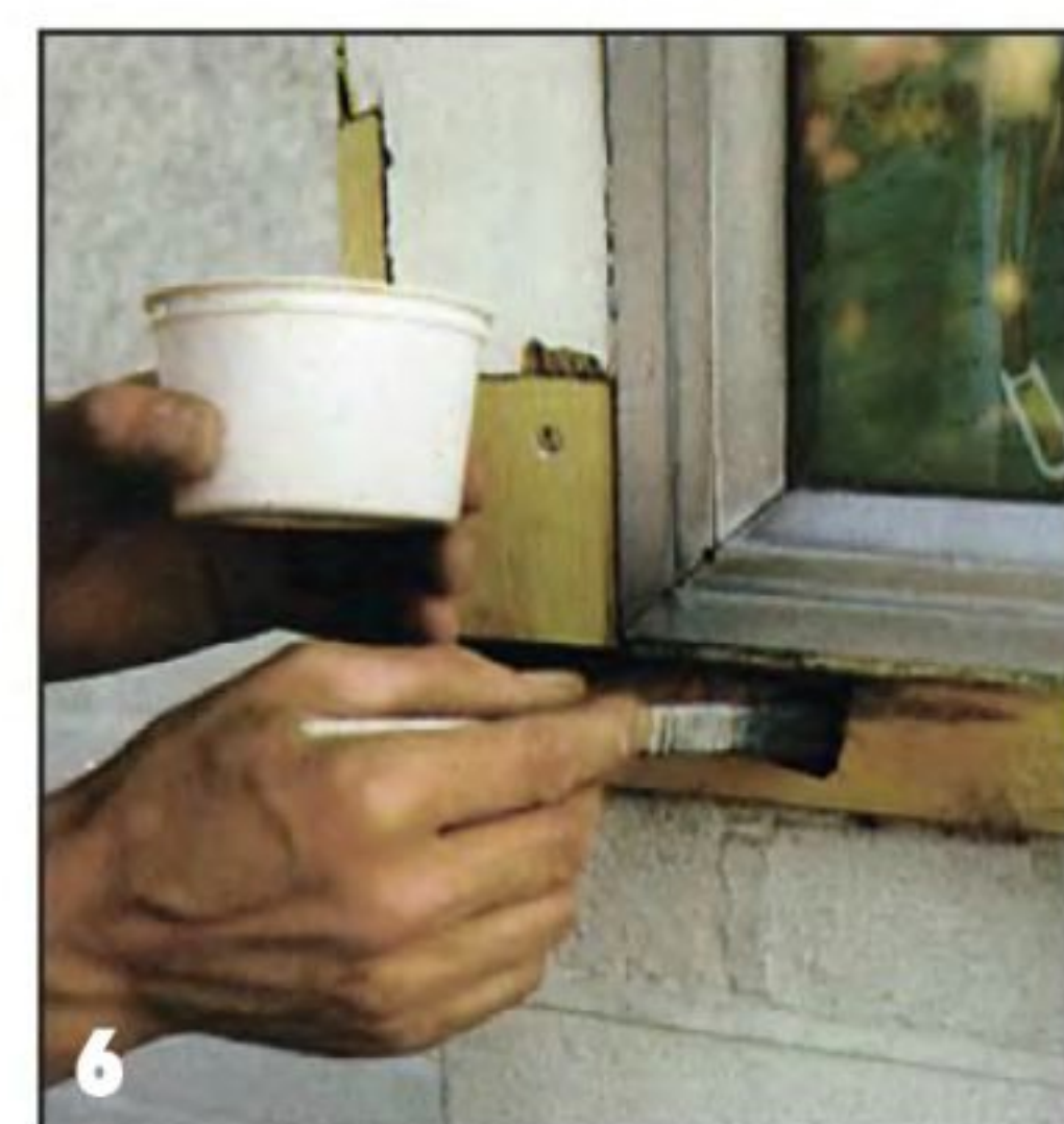
6 Вязкотекучий двухкомпонентный клей обильно наносят на контактирующие поверхности.
