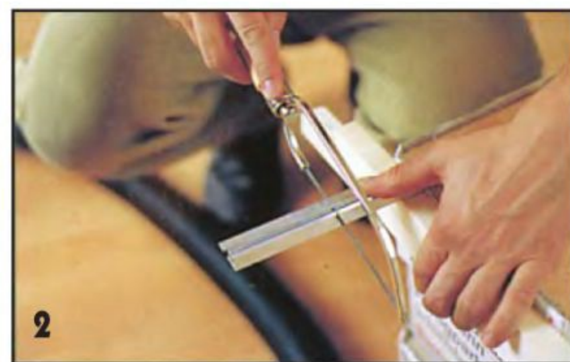
Элементы шины из алюминия можно легко распилить обычной ножовкой по металлу.
