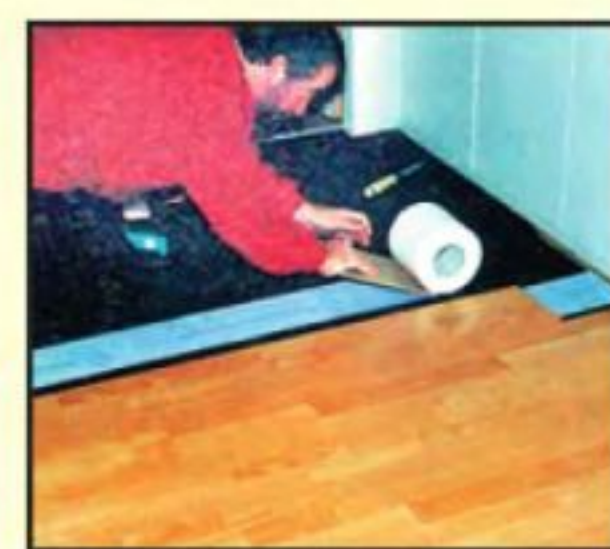
Смещения уложенных таким способом элементов ламината не произойдёт. Теперь можно приступить к укладке следующего ряда
