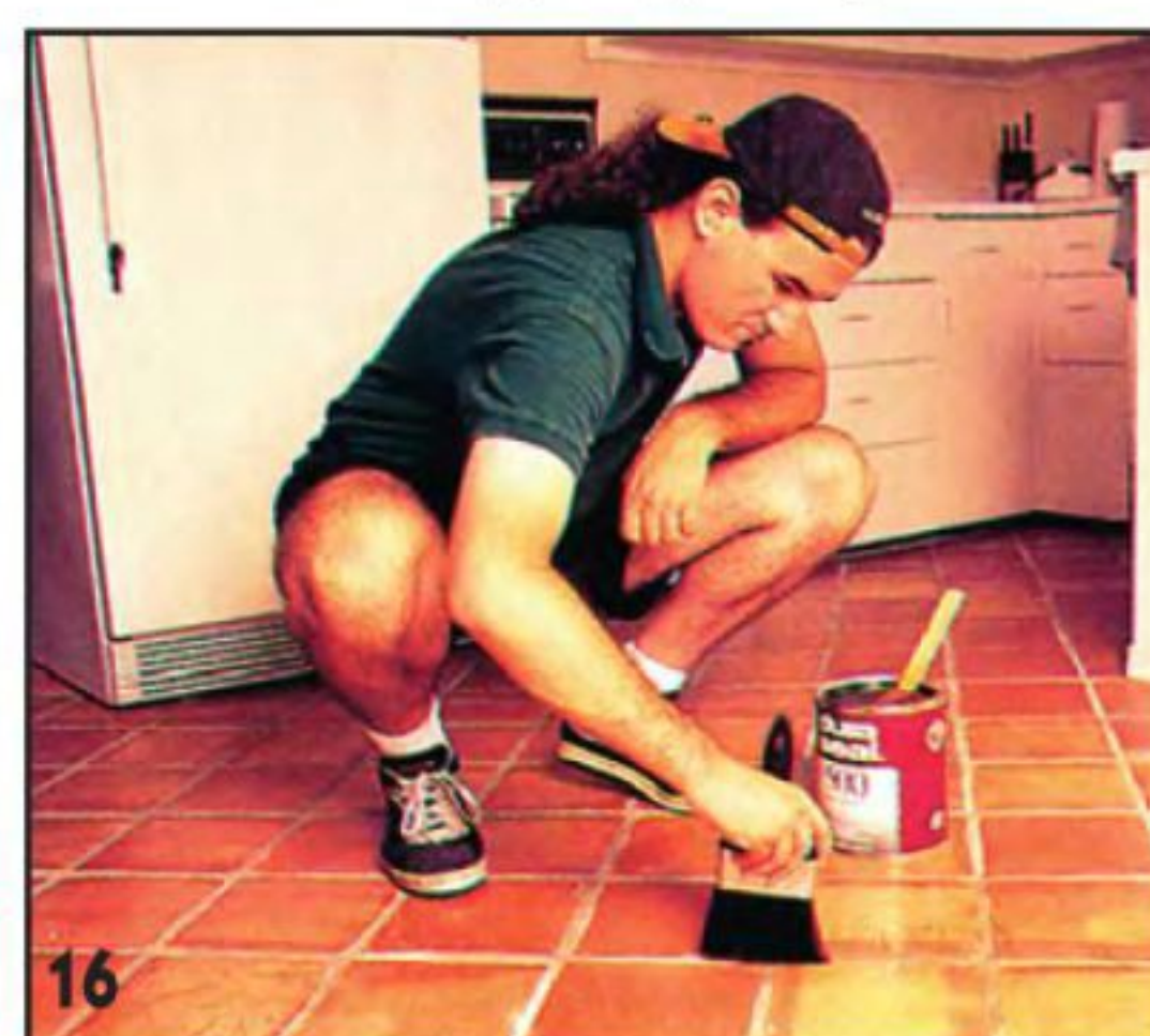
Три недели спустя, когда затирка и клей полностью затвердели, настало время последнего штриха. Неглазурованную плитку надо защитить от влаги, грязи и пятен. Для этого кистью покрывают плитку специальным составом и хорошенько втирают его в швы.
