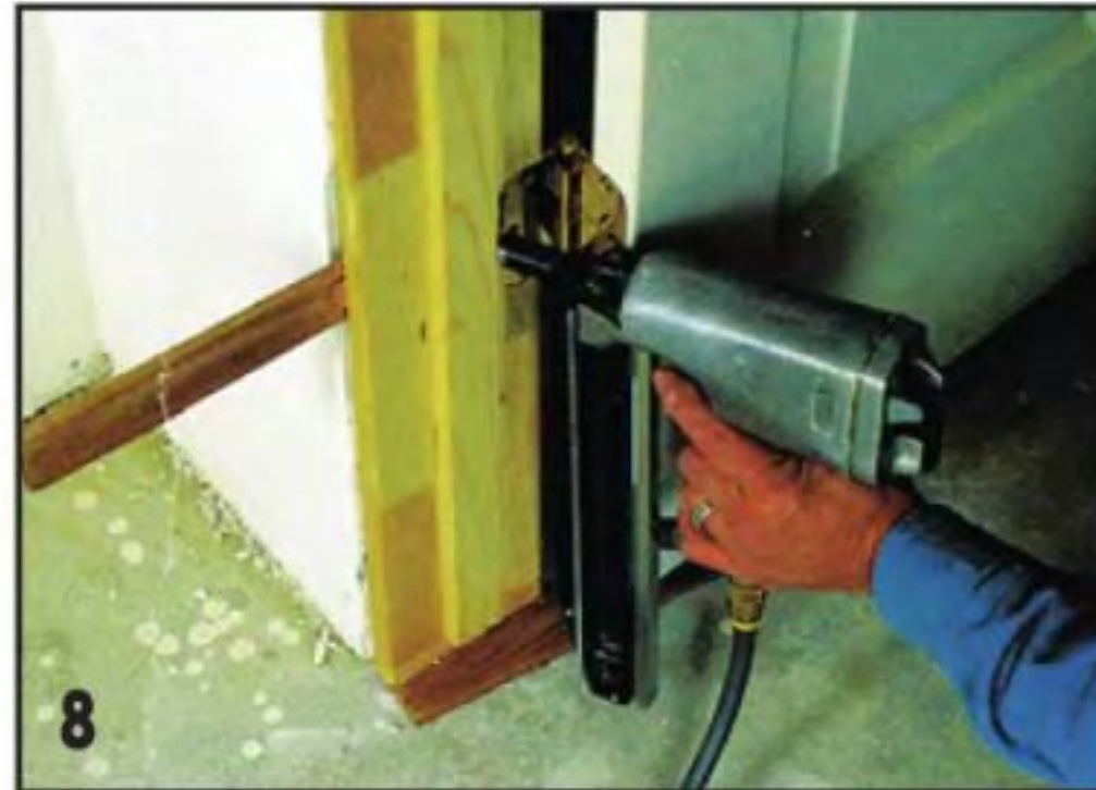
8 Гвоздями прибивают обвязки к стойкам (торцам стены), вбивая их рядом с петлями. Гвозди обязательно должны пройти сквозь клинья.
