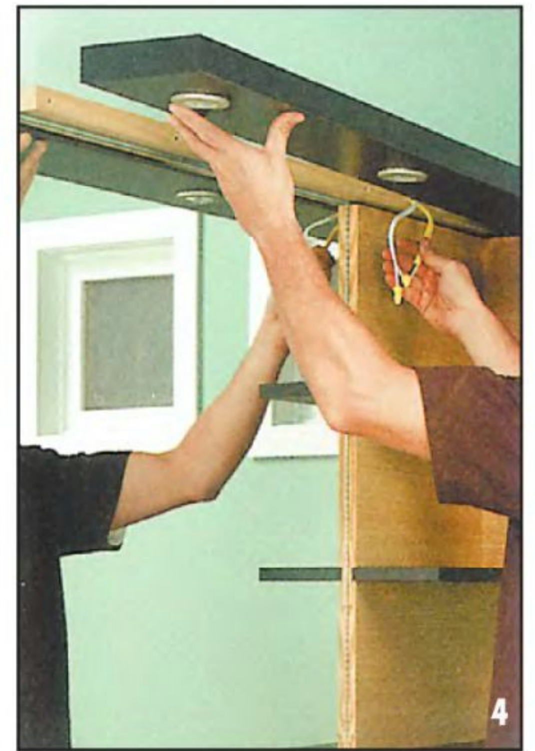
4 Установив и подключив светильники, крепят карниз.
