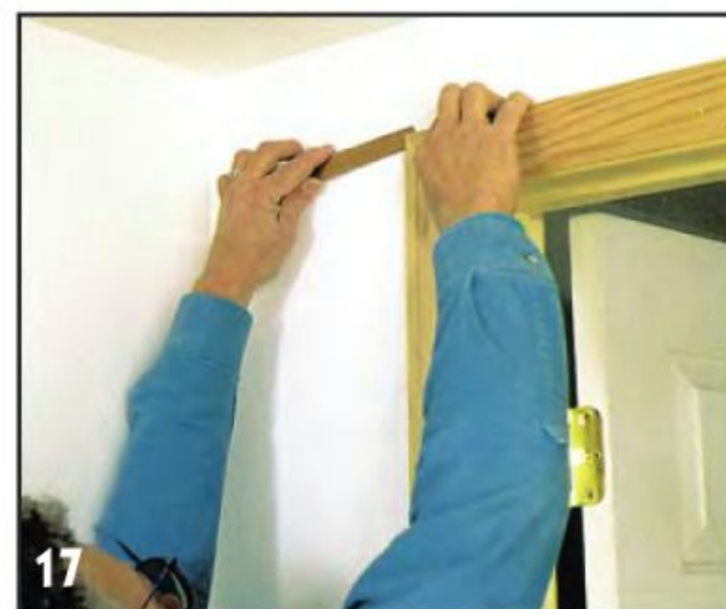
17 Если наличники не лежат в одной плоскости, их выравнивают клином, а затем ножом обрезают клин заподлицо с наличниками.
