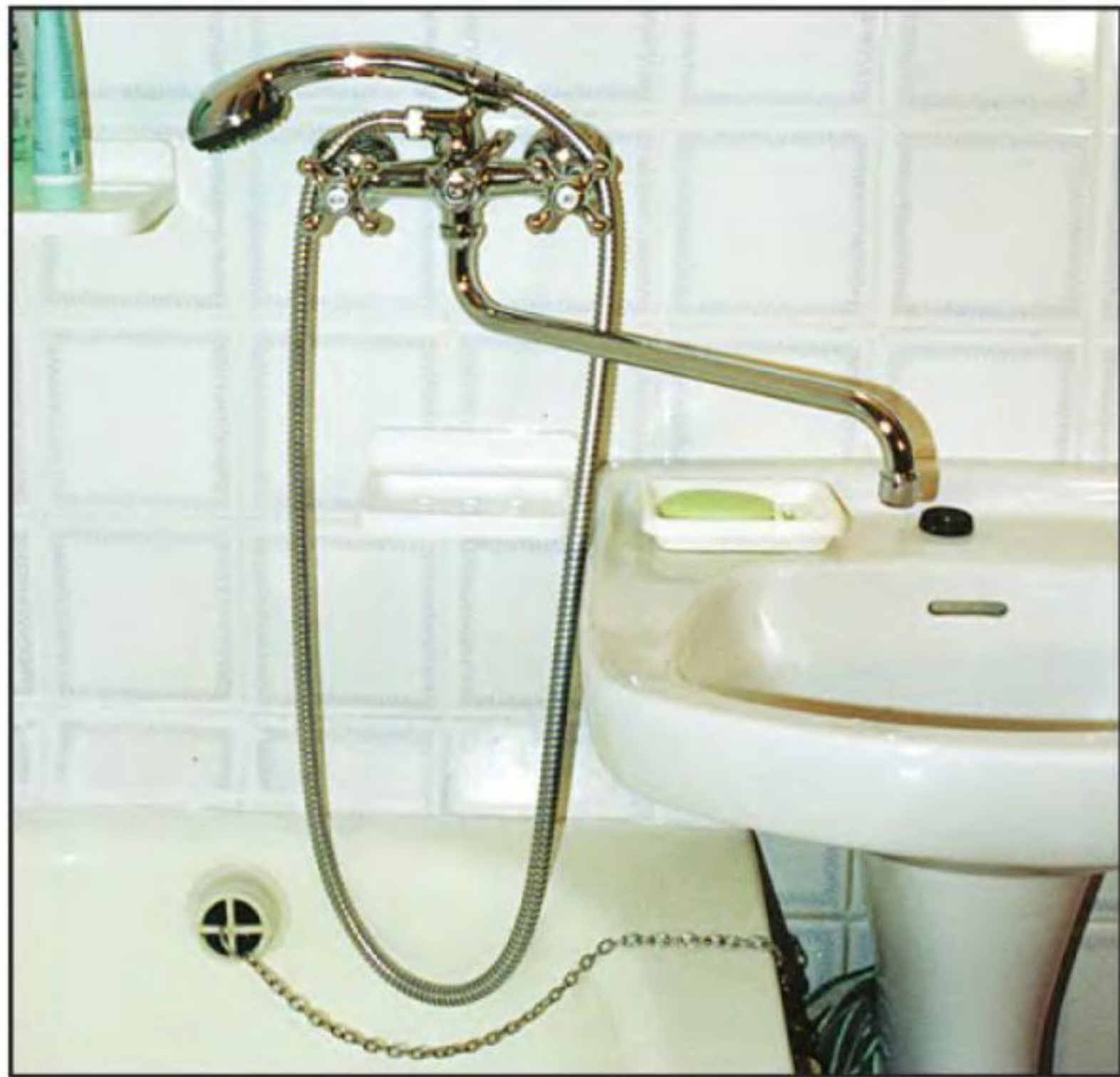
Перед началом работ со смесителем первым делом перекрывают подачу горячей и холодной воды. Краны смесителя при этом должны быть открыты.
