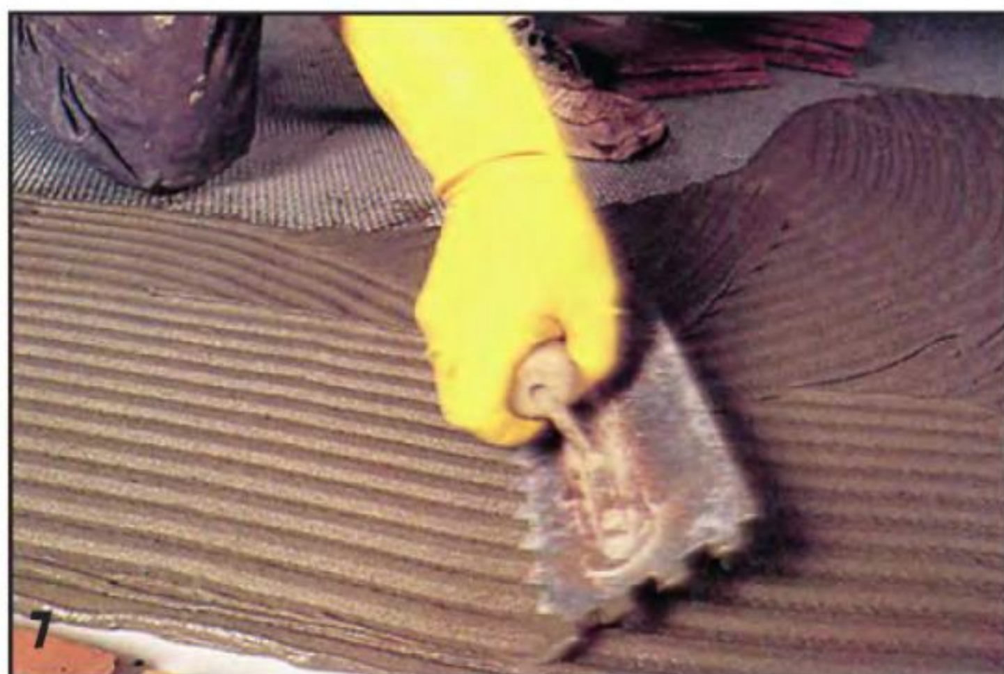
7 Над сеткой клей разравнивают зубчатым шпателем. Благодаря волнистой поверхности клеевого слоя после укладки плитки клей равномерно растекается по её тыльной стороне.
