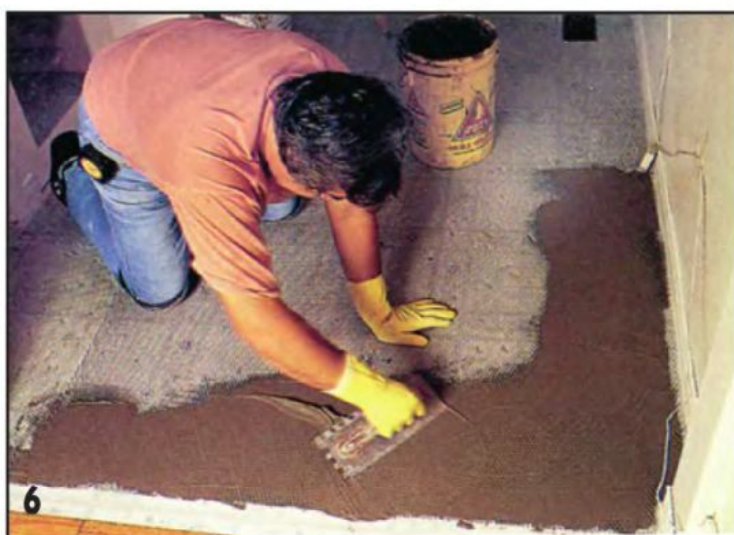
Сначала плиточный клей на основе цемента втирают в армирующую проволочную сетку ровным ребром шпателя. Приблизительно через 10 минут клей начнёт схватываться, поэтому наносят его на небольшой участок пола.
