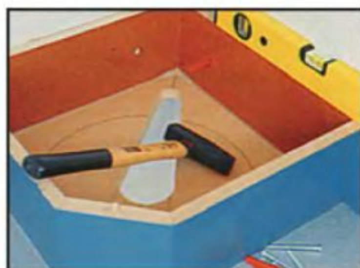
Выставляют полку горизонтально с помощью уровня и крепят к стенам на шурупах с дюбелями.
