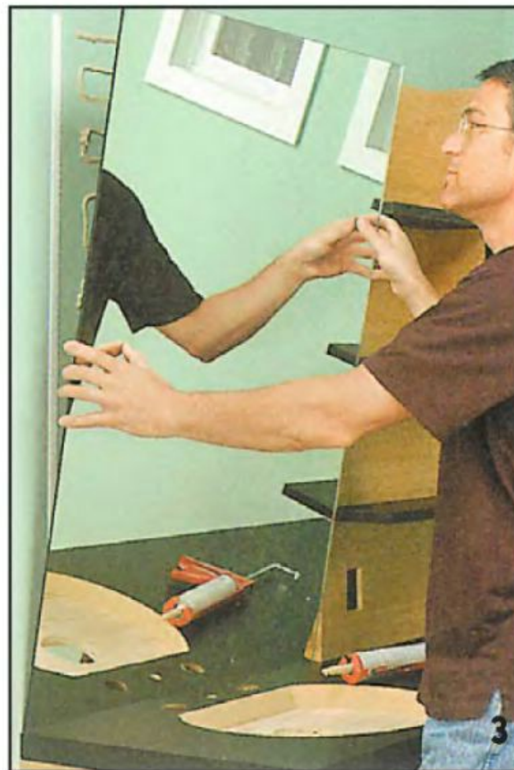
3 Зеркало приклеивают непосредственно к стене специальным клеем.
