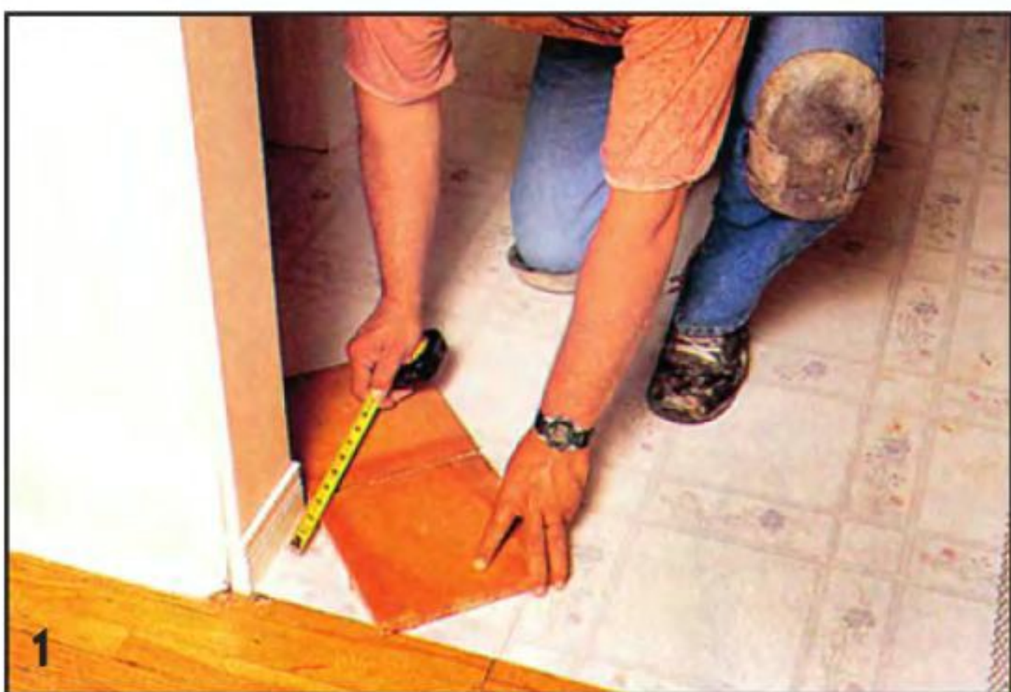
Так как плитка должна быть уложена диагонально (под углом 45° к стенам), разметку начинают от дверного проёма.
