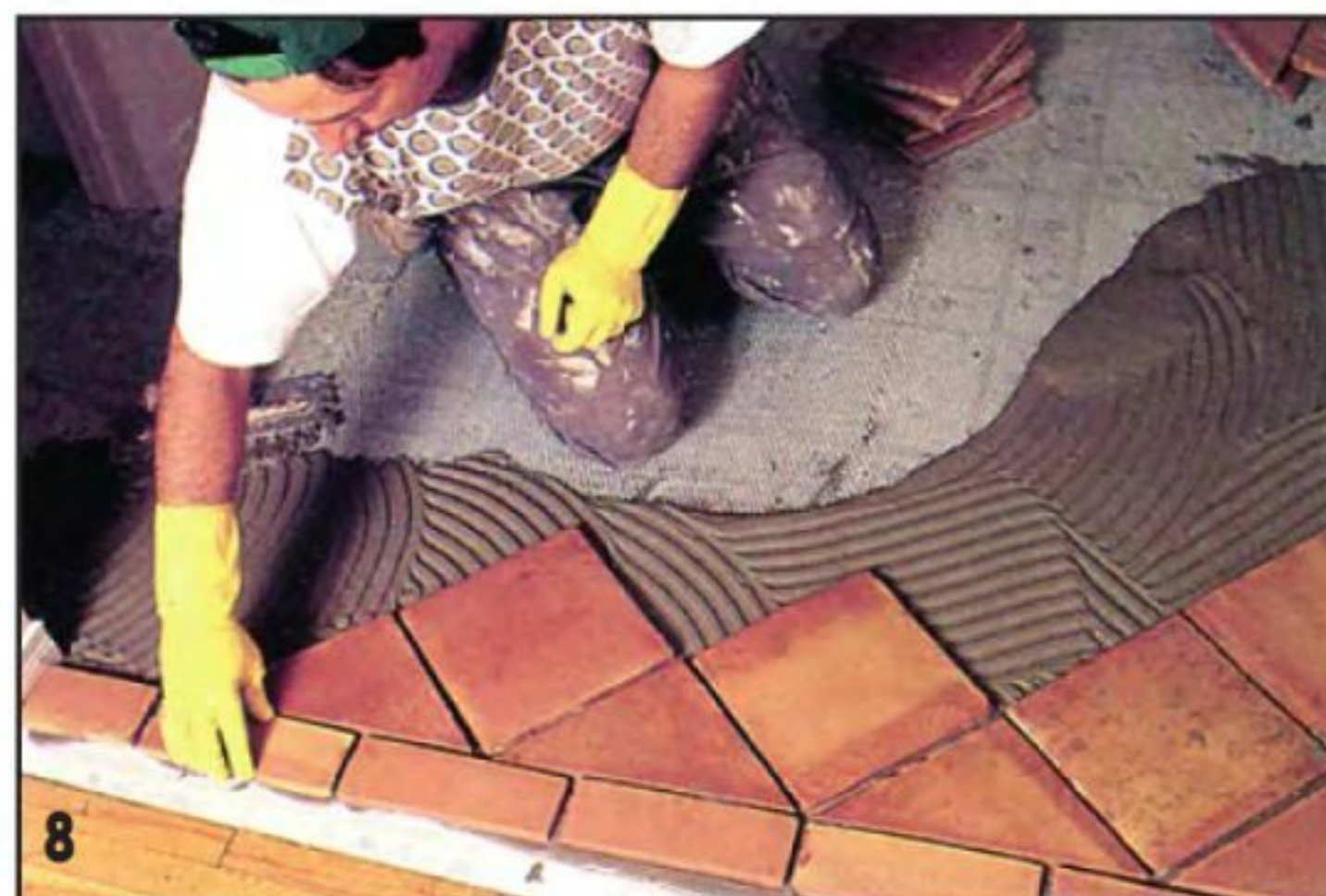
8 Так как кромки плиток — неровные, швы между плитками оставляют широкие и делать их лучше на глаз. Прочно посадить на место и выровнять плитки по высоте поможет резиновая киянка.
