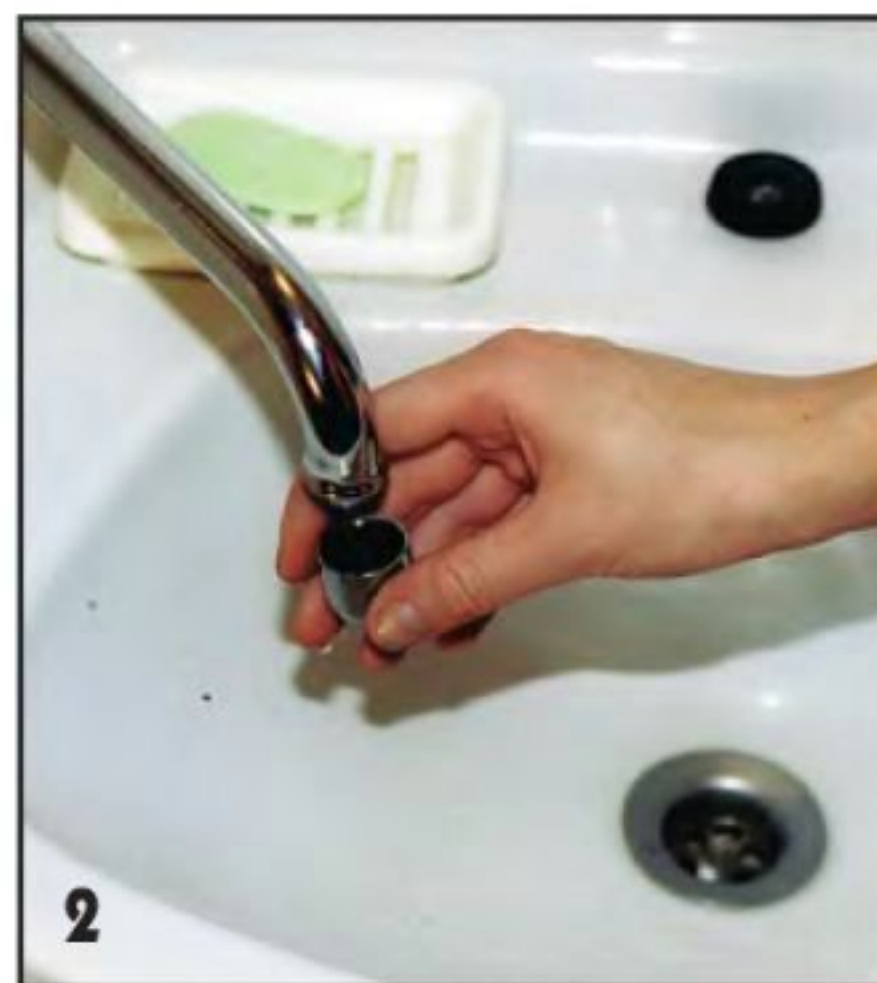
Несмотря на то, что перед смесителем в трубы врезаны фильтры-пробки механической очистки воды, сетки рассекателя-аэратора в колпачке излива всё равно засоряются со временем. Поэтому колпачок свинчивают с излива, вынимают из него и разбирают блок с сетками.
