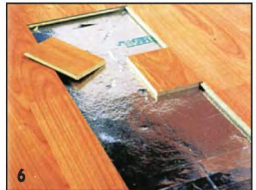
6 Качество подготовки элементов шпунтового соединения проверяют с помощью обрезков от старой доски. Левый обрезок используют для проверки паза, правый - для проверки гребня.
