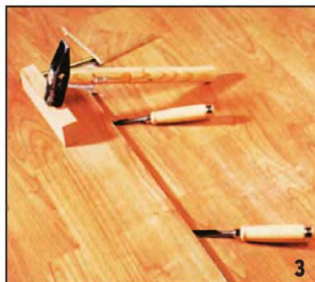
Приподнимают стамесками продольные сегменты, простукивают молотком через монтажный брусок зону шпунтового соединения и после разрушения клеевого шва сегменты удаляют.
