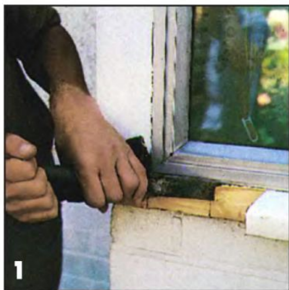
1 Повреждённые места деревянного карниза удаляют с помощью ножовки по дереву и стамески с последующей зачисткой «обнажённых» поверхностей.
