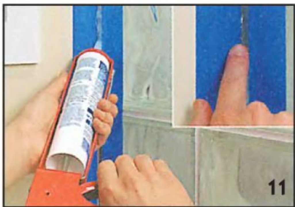
11 Стыки между возведённой стенкой из стеклоблоков, поддоном и панелями обшивки стен ванной заполняют силиконовым герметиком.
