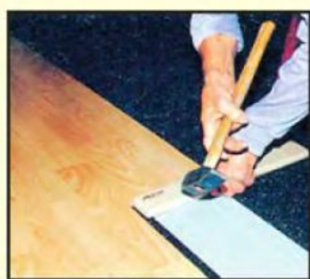
На самоклеящуюся ленту, с которой ещё не снята защитная плёнка, кладут очередной элемент ламината и прищёлкивают его к уже уложенному.
