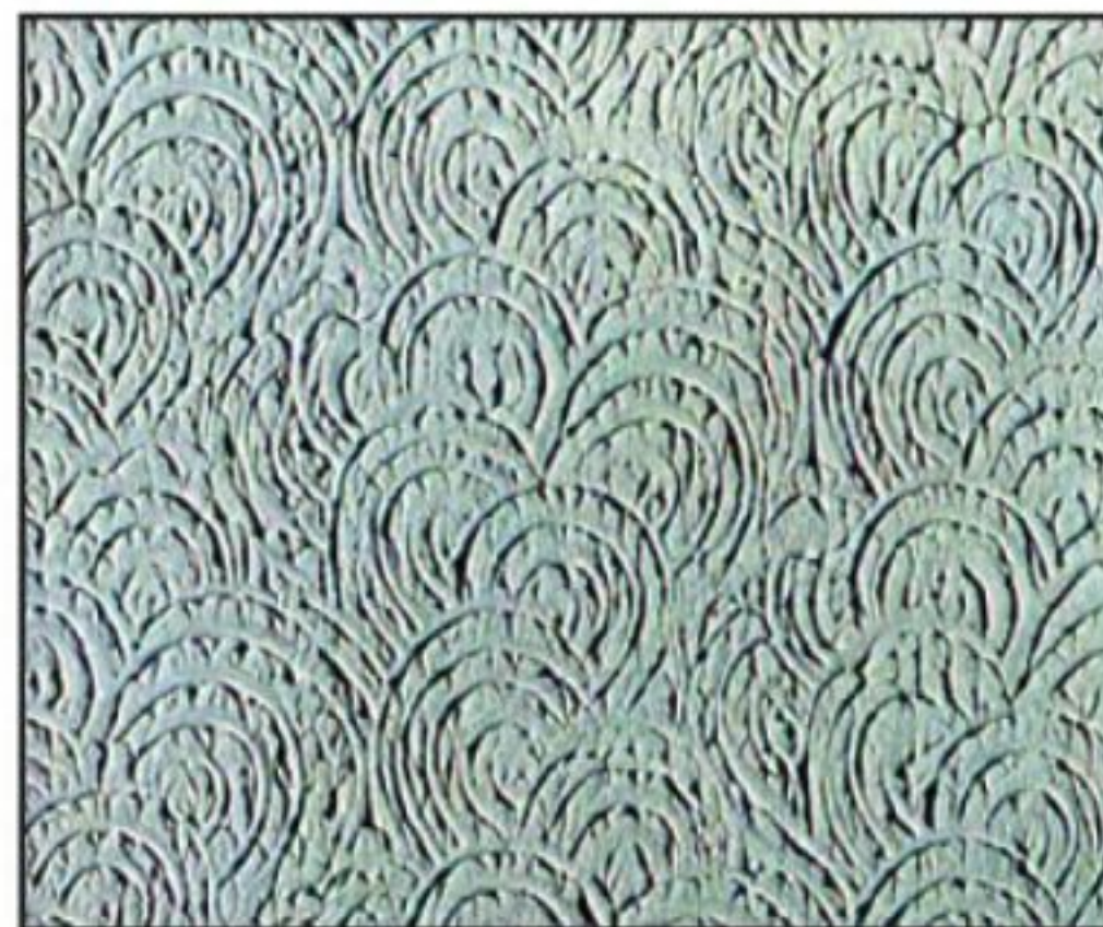
Декоративная текстура стены лестницы создана узорным валиком.
