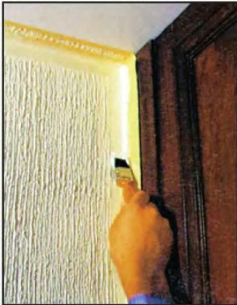
При прокатывании стены пористым поролоновым валиком получается неравномерная «шершавая» фактура.
