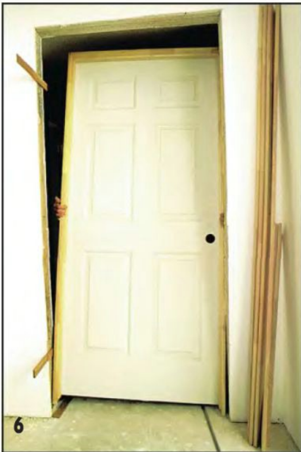
6 Устанавливая дверь на место, обвязку со стороны петель опирают на толстый конец клина, уложенного на пол.
