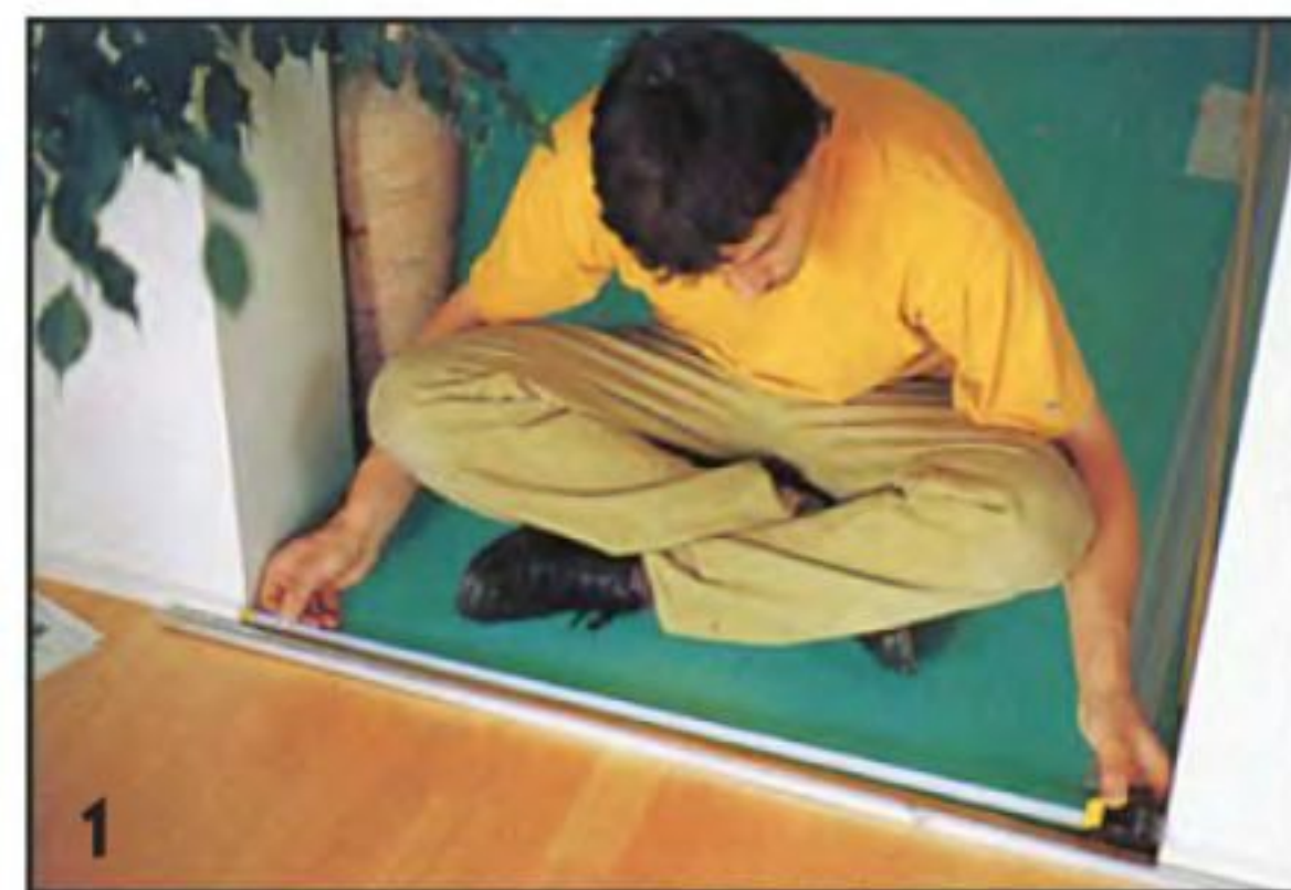
Поскольку плинтусы будут крепить и подгонять позднее, длина профиля должна соответствовать ширине проёма.
