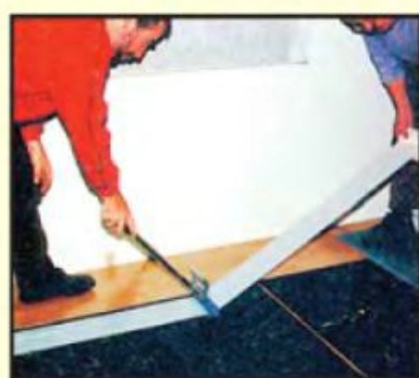
К уложенной подкладке, препятствующей распространению ударных шумов, перед настилкой очередного ряда ламината приклеивают двустороннюю самоклеящуюся ленту.
