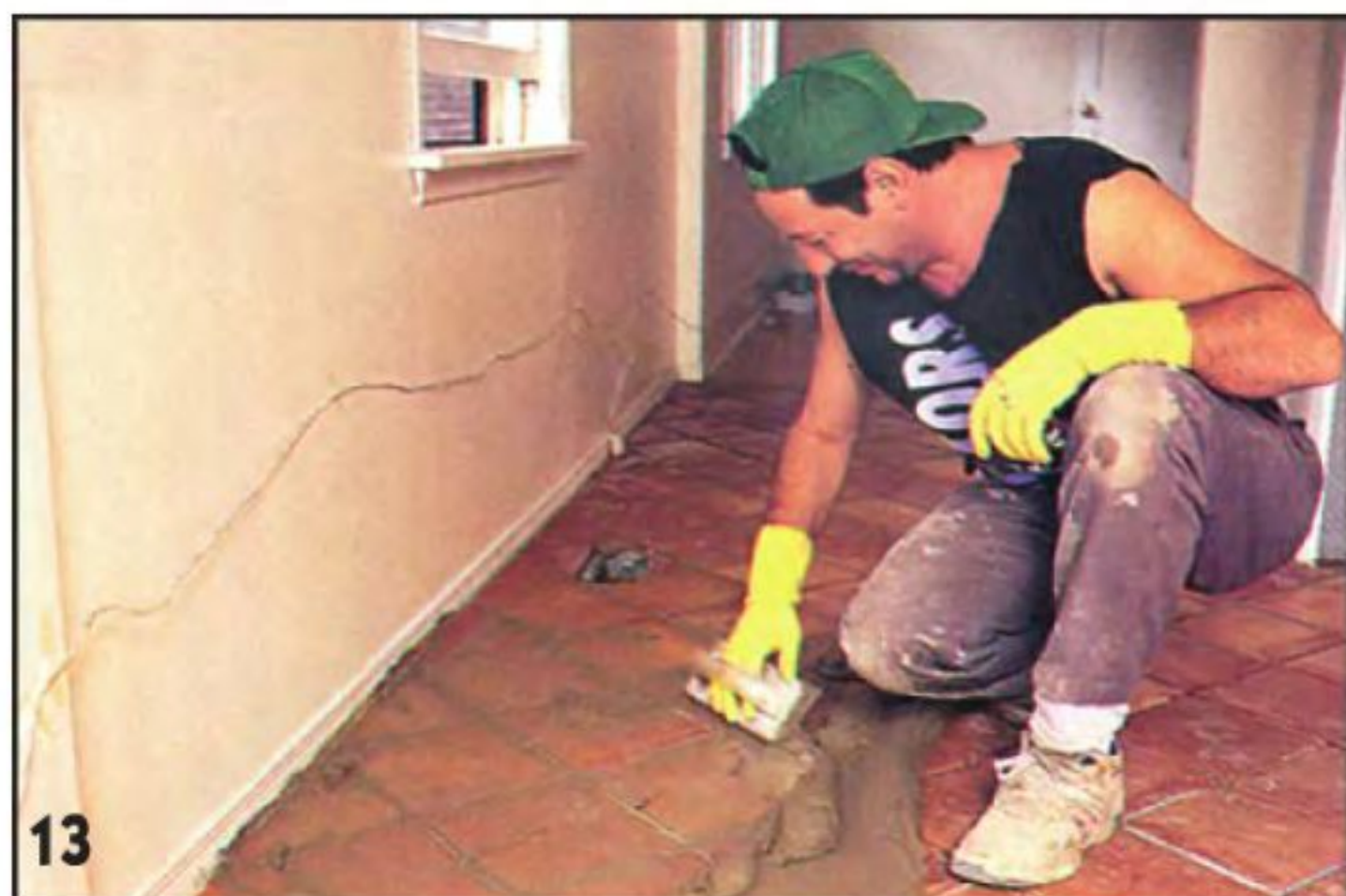
Подготовленная затирка для швов очень похожа на плиточный клей. Её наносят тоже маленькими участками. Заполняют швы движениями тёрки под углом 45° к швам.
