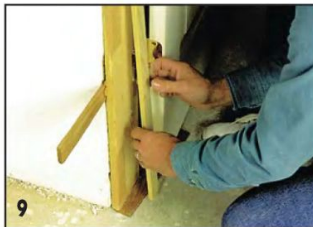
9 Снимают ограничители хода двери и вворачивают под ними шурупы, крепящие обвязку к стойке (к торцу стены).
