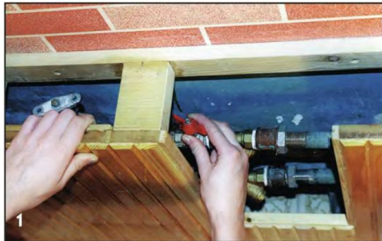
Перед началом работ со смесителем первым делом перекрывают подачу горячей и холодной воды. Краны смесителя при этом должны быть открыты.
