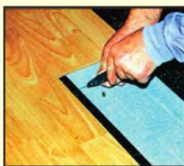
Чтобы можно было зафиксировать элемент, самоклеящуюся ленту обрезают у его торцевой кромки.
