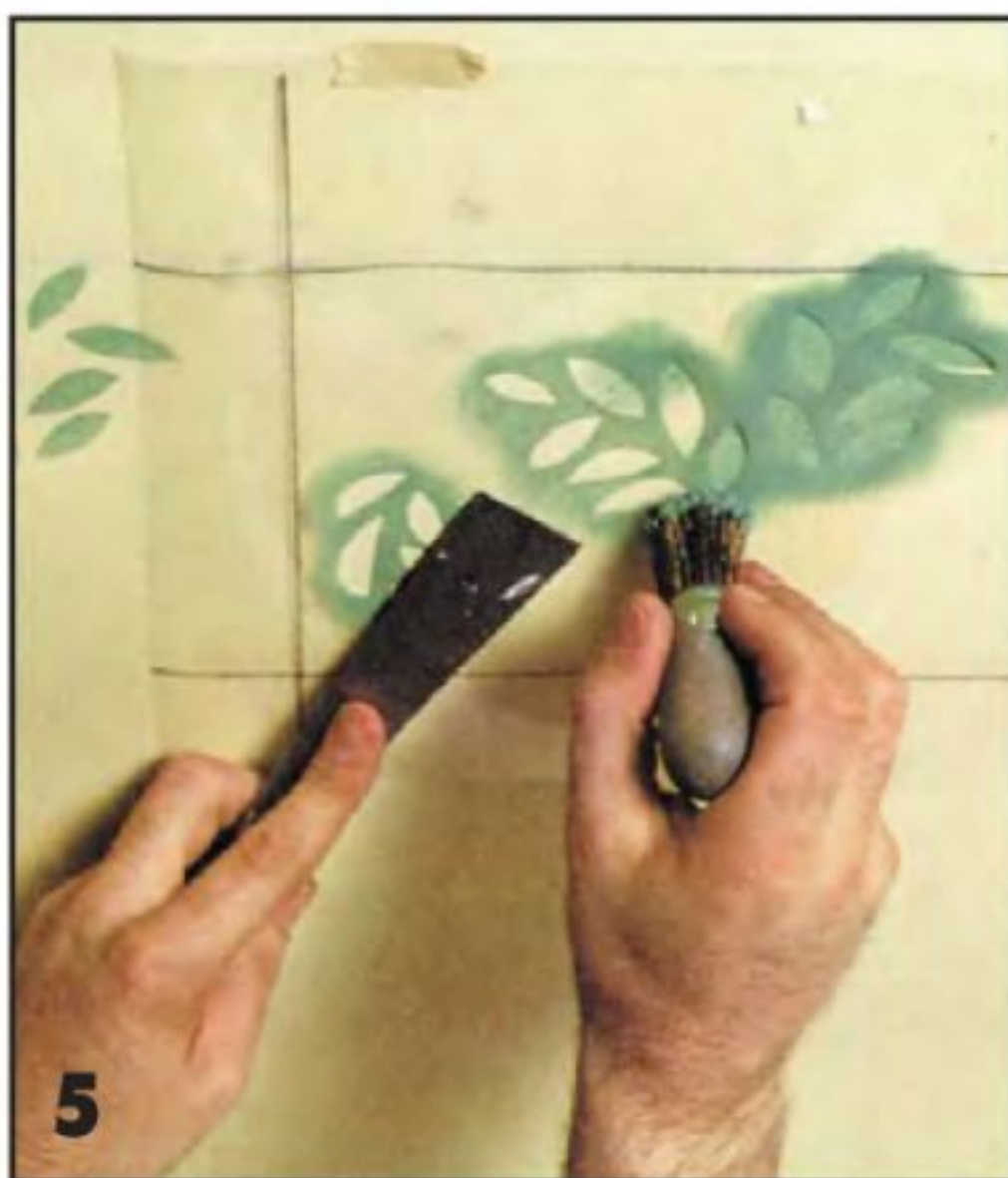
При нанесении краски кистью трафарет прижимают к стене шпателем.
